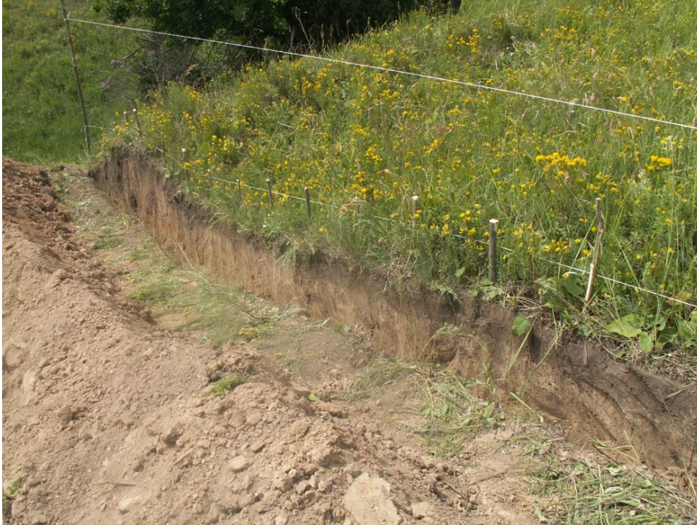
Рис. 2. Общий вид траншеи Fig. 2. General view of the trench
